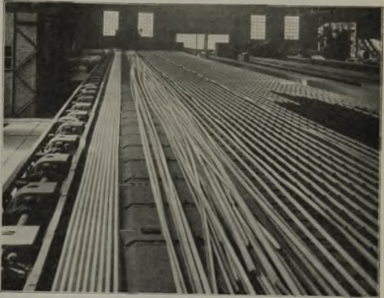
Abbildung 1. Ungeordnet vom Kühlbett bisheriger Bauart herunterkommende Walzstäbe.
