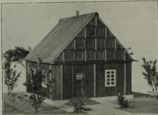
Abbildung 2. Außenansicht des Stahlhauses, Versuchsausführung Duisburg.
