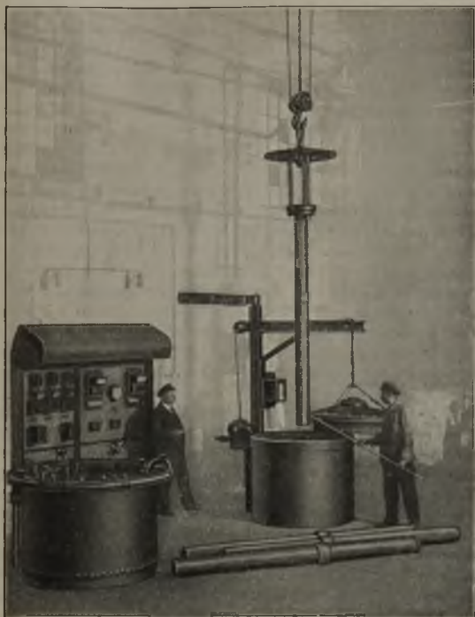
Abbildung 2. Ansicht des neuen Elektroglohubofens.
