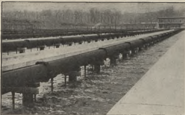
Bild 3. Schlammbelebungsbecken der Pariser Anlage.
