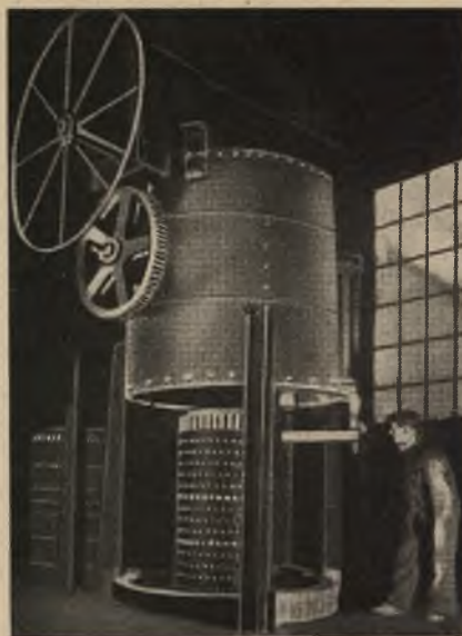
Bild 1. Elektrischer Brown - Boveri-Gießpfannenwärmer, 100 kW, 500 V: für 12-t-Gießpfannen. Aufsetzen durch Führungen geschützt.
