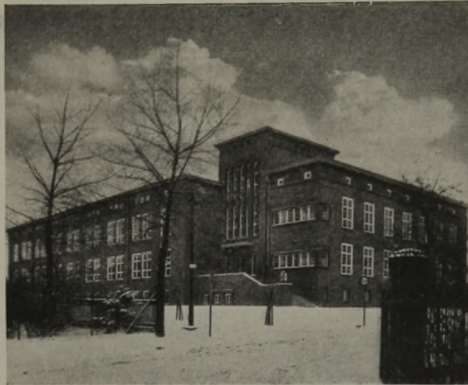
Abb. 1. Ansicht des Gebäudes.
