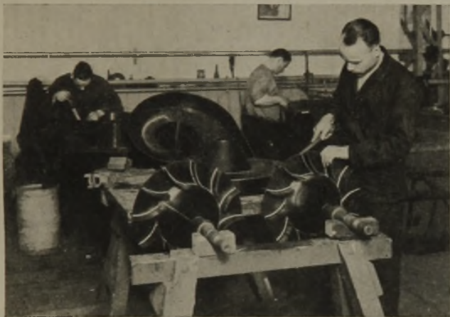
Abb. 2. Flügelräder und Gehäuse vor dem Zusammenbau.
