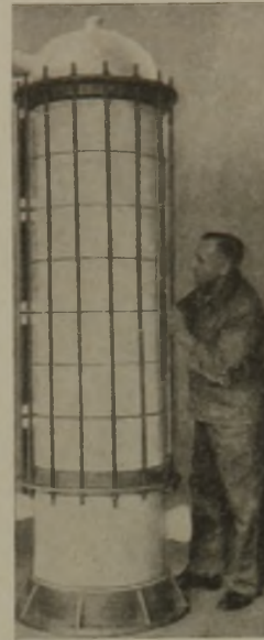
Abb. 1. Kühlturm, bestehend aus Einzelelementen.
