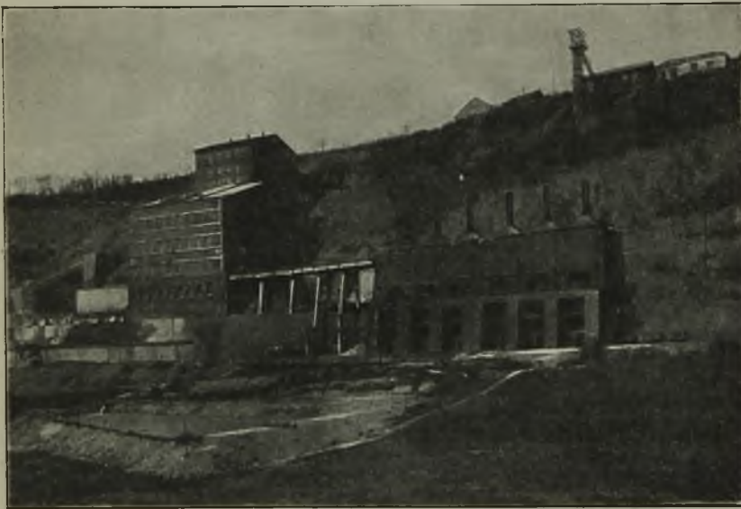
Abbildung 1. Gesamtansicht der Röstanlage.
