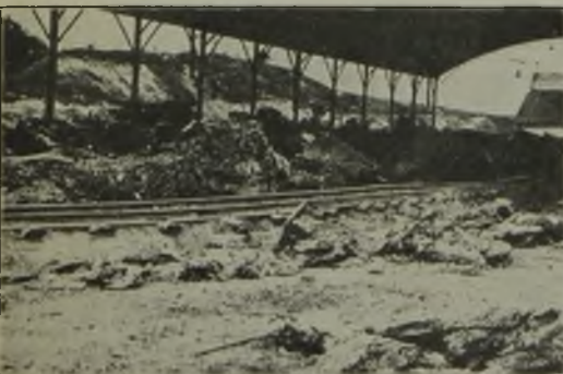
Abbildung 3. Schlechte Flur- förderung für das Verladen von Schlacke.
