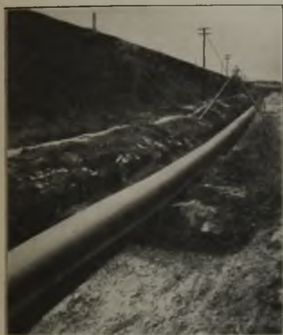
Abbildung 3. Versenken der Rohrleitung in den Rohrgraben.
