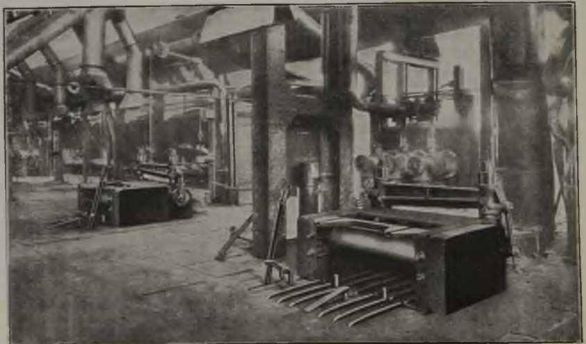
Abbildung 8. Blechdoppler, Bauart Demag.
