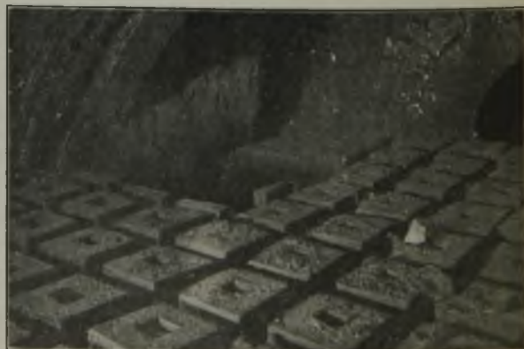
Abbildung 8. Blick in eine mit dem neuen Lochstein ausgepackte abgestellte Luftkammer.
