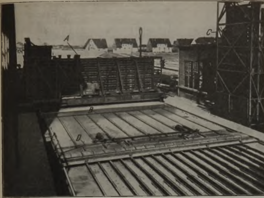
Abbildung 6. Koksförderwagen und Rampe mit Einwurfschlitzen für die Löscheinrichtungen.
