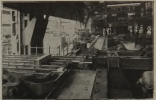
Abbildung 3. Blockschere II mit Abschiebevorrichtung und Klinkenschlepperwarmbett.
