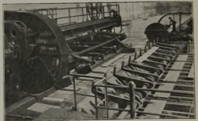
Abbildung 9. Kühlvorrichtung für Platinen mit Auswurfhebeln und Klinkenschlepperwarmbett.
