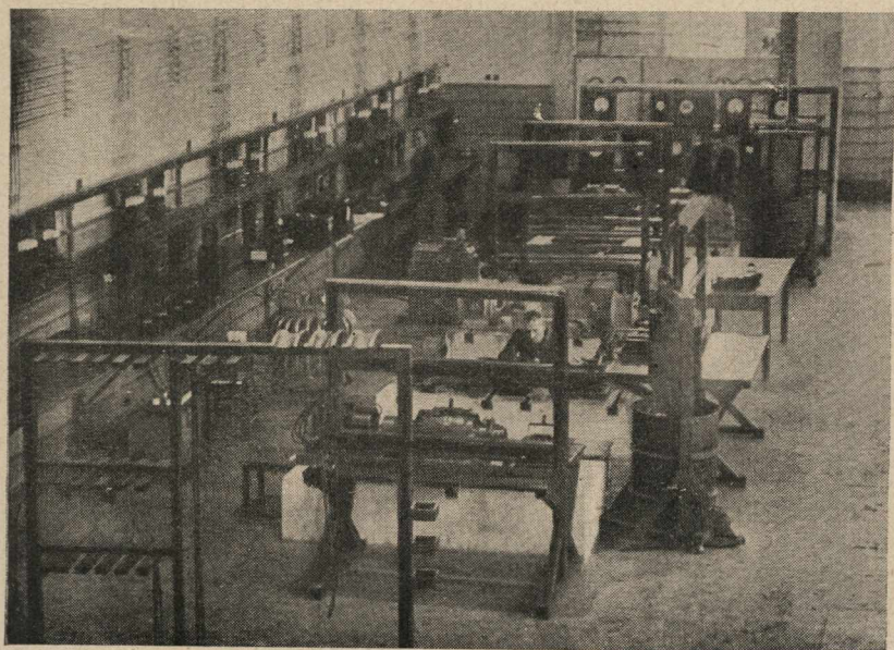
Wydz. elektryczny. — Hala maszyn
