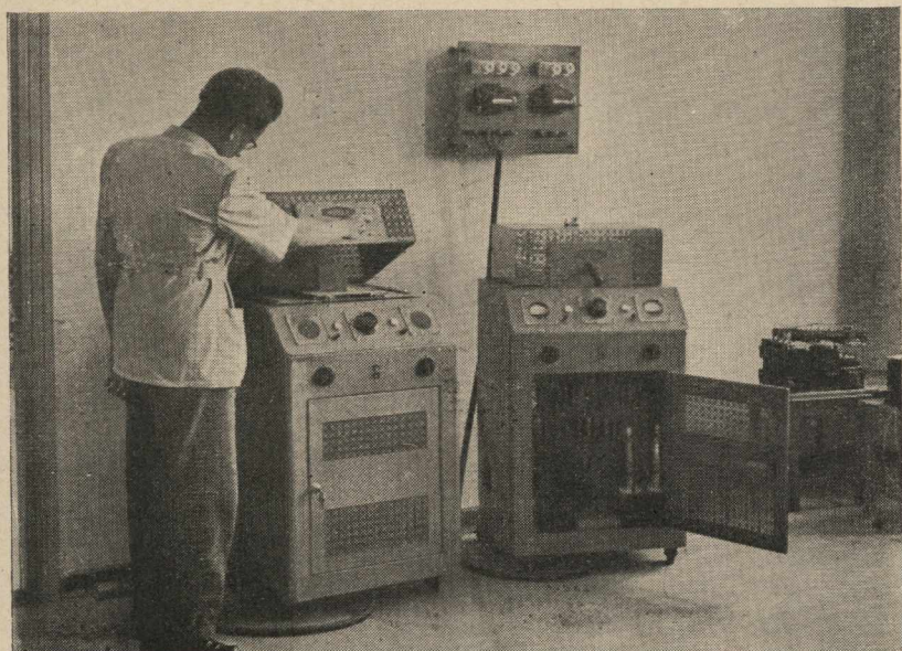
Piece elektryczne do badania materiałów izolacyjnych
