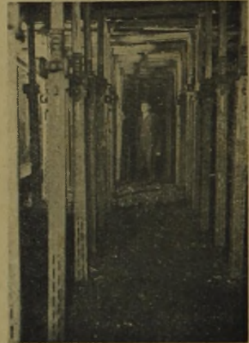
Abb. 10. Reihenstempelbruchbau im Georgflöz der Preußengrube.
