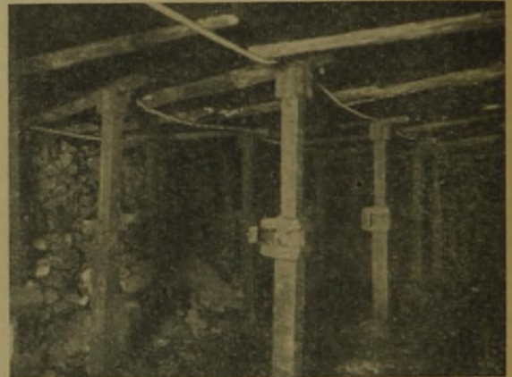
Abb. 8. Drahtseilausbau.
