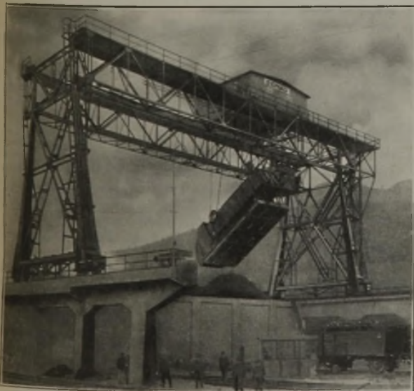
Abbildung 2. Kipperkatzen-Verladebrücke auf den Wänden eines Erzbunkers.
