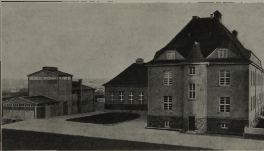
Abbildung 1. Gesamtansicht des Eisenhütten-Instituts der Sächsischen Bergakademie.
