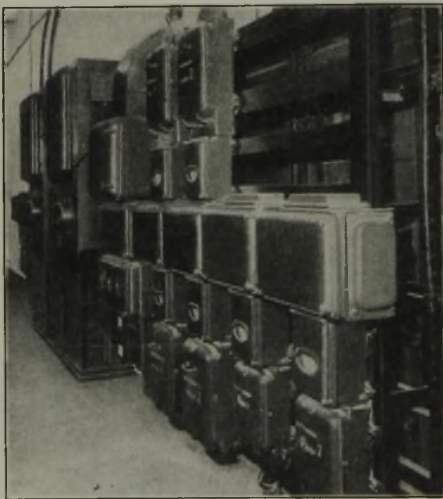
Abbildung 11. Gußeisengekapselte Unterverteilungsanlage.
