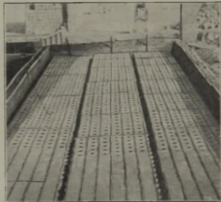
Abbildung 2. Gießfertiges Pflastersteinbett.
