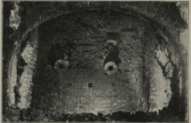
Abbildung 3. Innenansicht der mit russischen Chrom-Magnesit-Steinen gemauerten Außenwand des Zuges.
