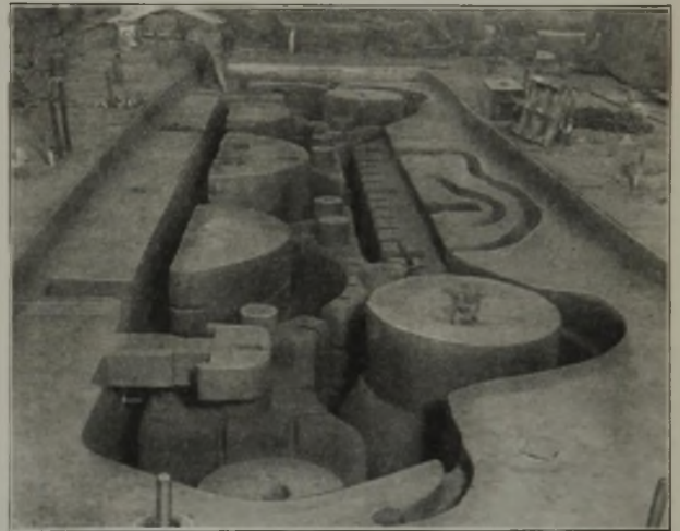
Abbildung 4. Gießform mit Kern für eine Seitenwange des Oberholms.
