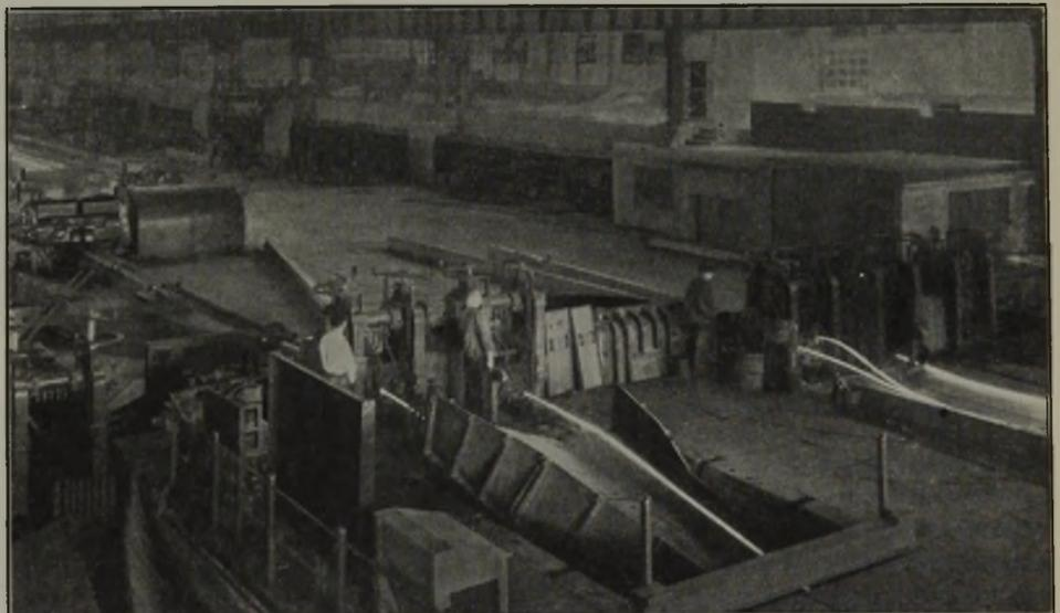
Abbildung 3. Fertigstraße des Draht- und Feineisenwalzwerks.
