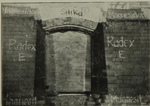
Abbildung 10. Neuzugestellte Vorderwand bei Siemens-Martin-Ofen 3. Türpfeiler: Radex E, Widerlager und Gewölbe über den Türpfeilern: Magnesidon, Türbögen: Silika.
