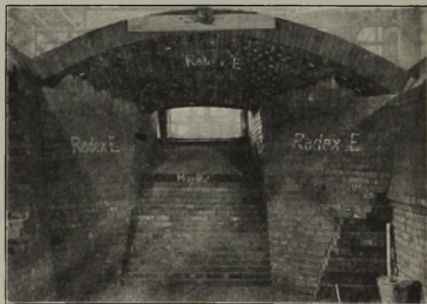
Abbildung 9. Neuzugestellter Brennerkopf mit Eckpfeiler und Satteltgewölbe aus Radex E bei Siemens-Martin-Ofen 3.
