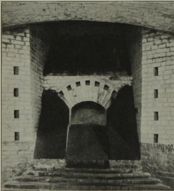
Abbildung 6. Ansicht des Ofenkopfes mit Kühlung durch Abgas.
