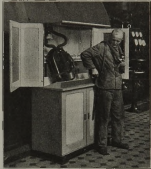
Abbildung 1. Geräteschrank des Gasschutzdienstes im Gebläsehaus.
