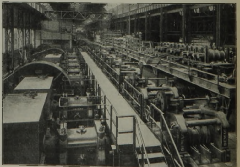
Abbildung 2. Straße 1 mit acht Gerüsten.
