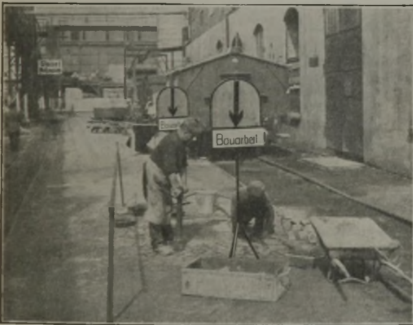
Abbildung 1. Bewegliche Gefahrenzeichen bei Instandsetzungsarbeiten.
