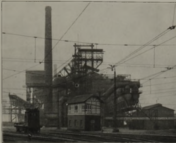
Abbildung 1. Ansicht der Hochofenanlage.
