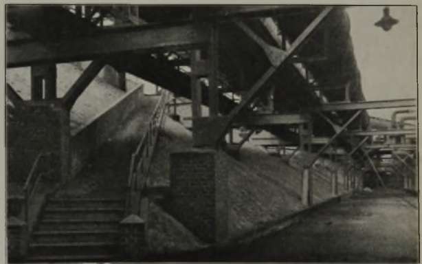
Abbildung 4. Neugestaltung einer Böschung.
