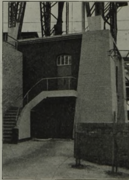
Abbildung 7. Pförtnerhaus in ein Turmfundament eingebaut.
