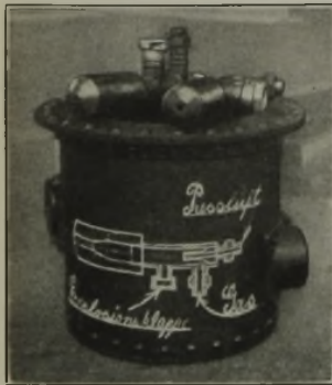
Abbildung 2. Gasgeheizter Schmelzofen für Bleimetalle.
