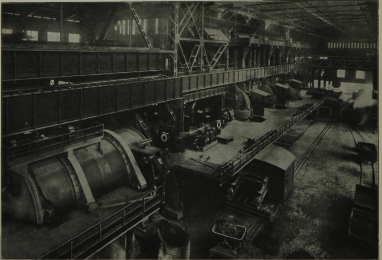
Abbildung 1. Innenansicht der Stahlwerkshalle.
