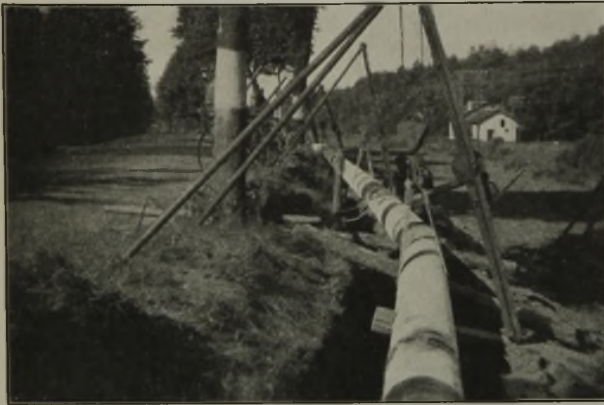
Abbildung 6. Versenken der geschweißten Leitung.
