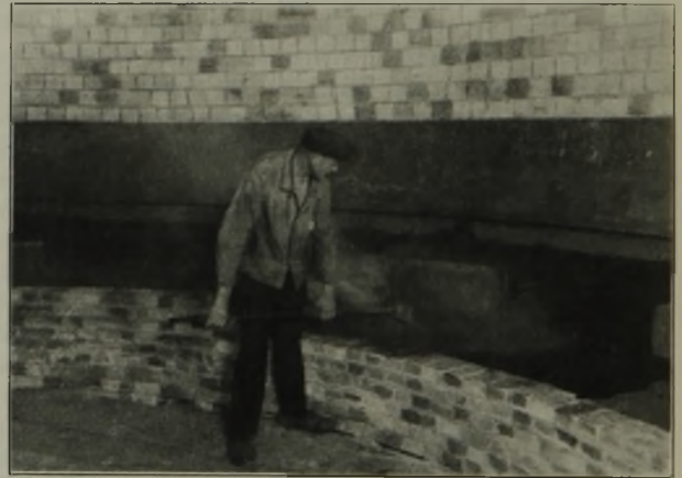
Abbildung 2. Einstampfen der Rastkühlkästen.
