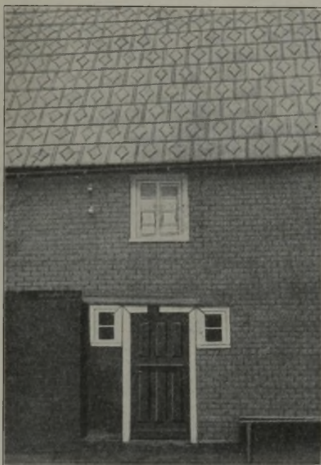
Abbildung 1. Das Dach ist mit häßlich gemusterten Blechpfannen gedeckt, die Wand mit Ziegelmauerwerk nachahmenden Blechen bekleidet.
