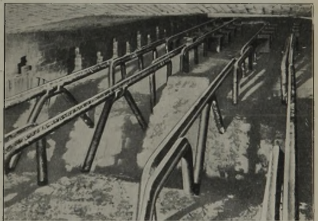
Abbildung 13. Doppelreihiger Stoßofen mit wassergekühlten Sprengwerken.
