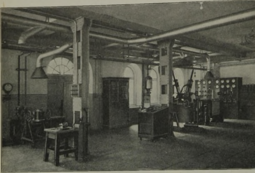
Abbildung 1. Teilansicht der Schmelzhalle mit Elektroöfen und fahrbarem Schalttisch.
