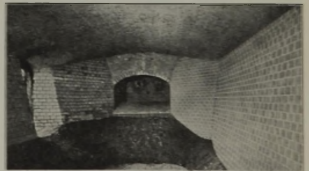
Abbildung 18. 30-t-Siemens-Martin-Ofen mit einem Luftzug und zwei Düsen. (Innenansicht.)
