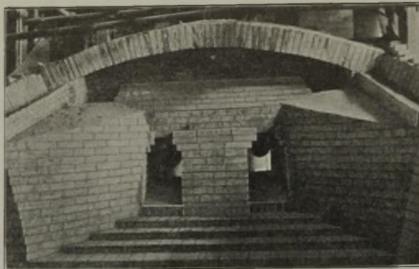
Abbildung 10. Kopf des 30-t.-Ofens I. (Zwei Primärluftzüge mit zwei Gasdüsen und zwei Sekundärluftzüge.)
