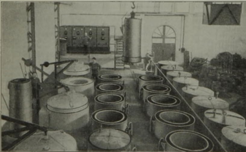
Abbildung 2. Blankglühanlage Siemens-Prüfert mit drei Schachtofen für je 85 kW Anschlußwert in einem Kaltwalzwerk.
