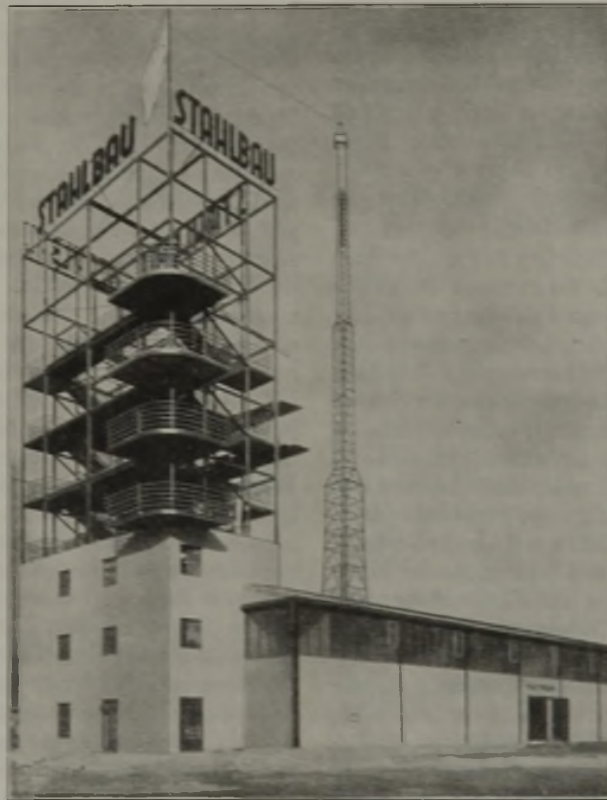
Abbildung 1. Halle „Stahlbau“ auf der Leipziger Messe.
