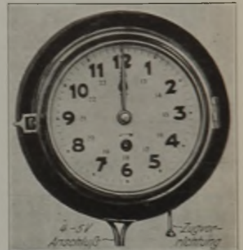
Abbildung 16. Uhr zur Zusammenzählung der Konverterblaszeiten. (Nach Bansen.) Nach der Ablesung wird die Uhr mit der Zugvorrichtung wieder auf 12 Uhr eingestellt.
