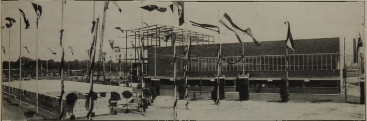
Der Bauplatz im Fahnschmuck.
