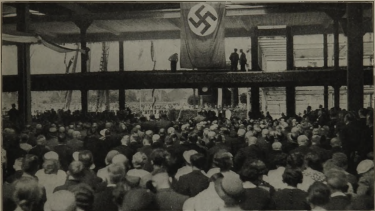
Blick aus der Festversammlung auf die Grundsteinlegung.
