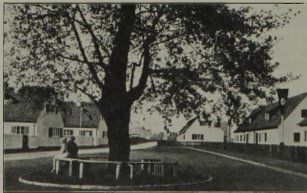
Abbildung 2. Eigenheimsiedlung der Firma Hoesch Köln-Neuessen, A.-G., in Dortmund-Kirchderne.
