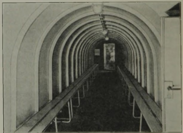
Schutzraum aus Stahllamellen.
