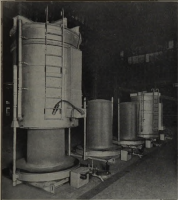
Abbildung 3. Haubenöfen zum Glühen von Stahlbändern.
