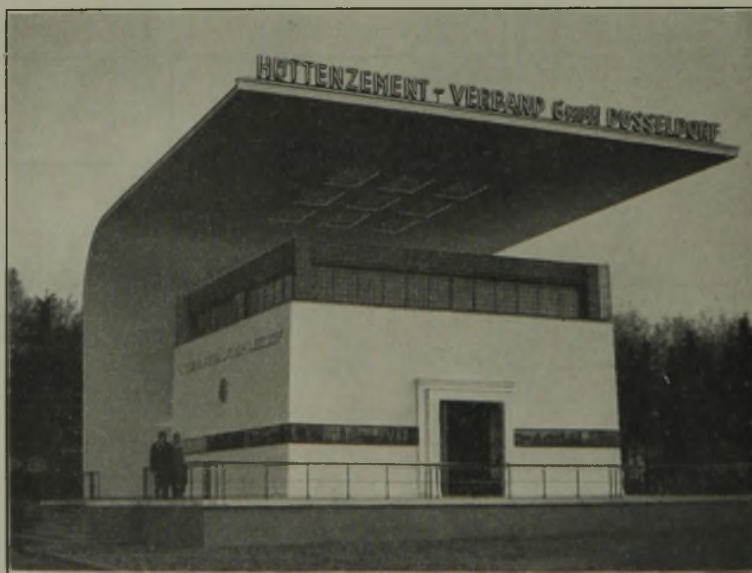
Halle des Hüttenzement-Verbandes. Breite des freitragenden Daches 14,75 m, Ausladung 18 m, Höhe über Straßenflur 9,50 m.
