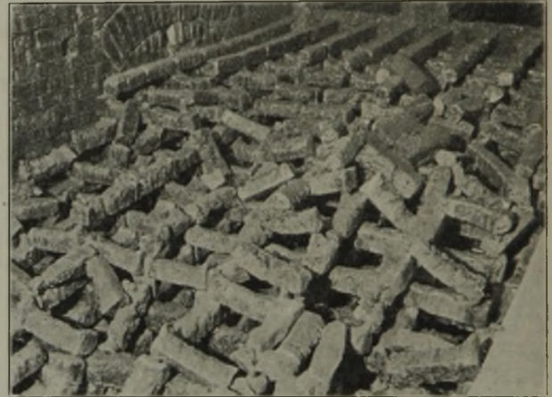
Abbildung 3. Verschleiß einer 100 mm starken Silikasteinpackung nach 381 Schmelzen.
