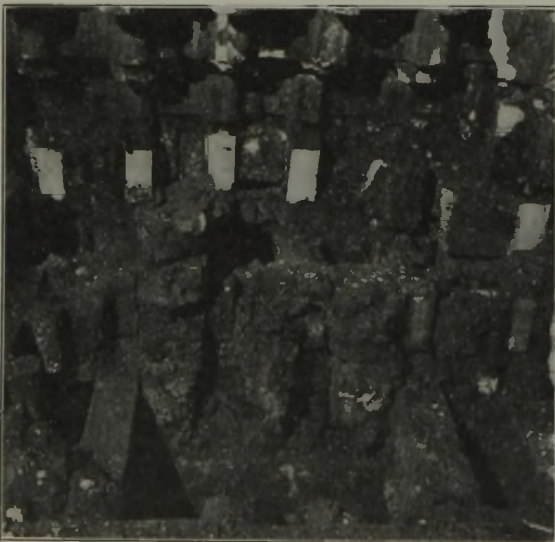
Abbildung 2. Durch abgelaufene Steine der oberen Lagen verstopftes Gitterwerk.
