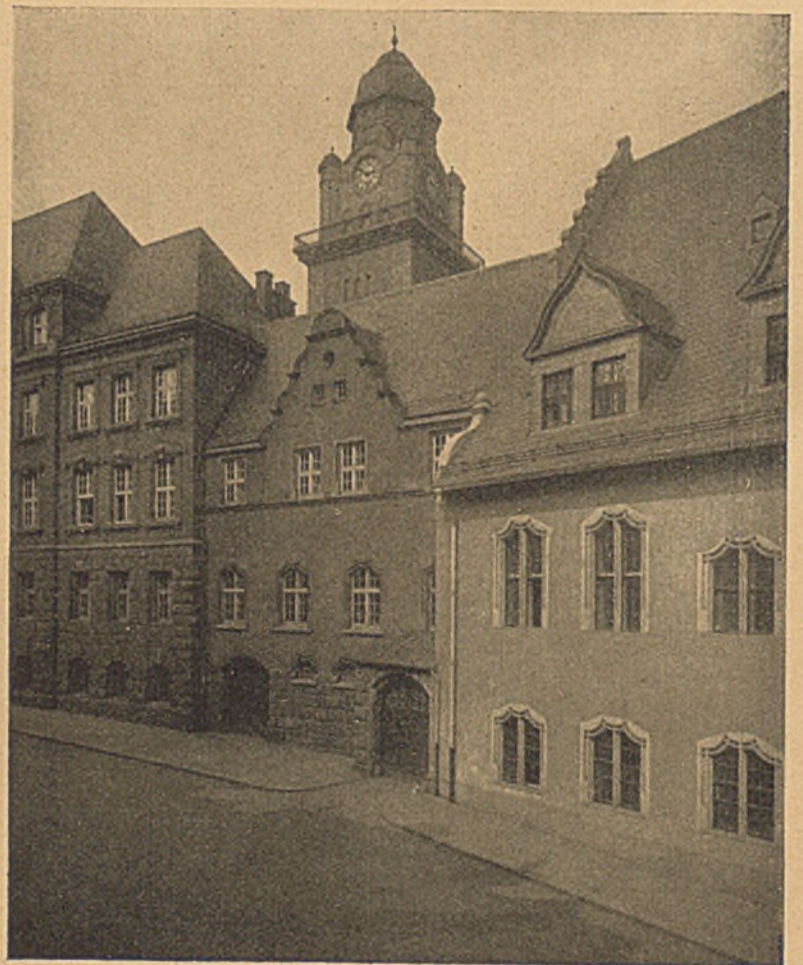
Zwischenbau an der Marktstrasse
