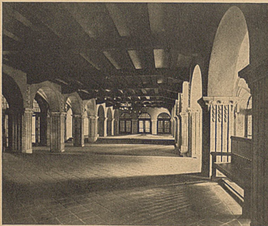
Halle im Erdgeschoss
