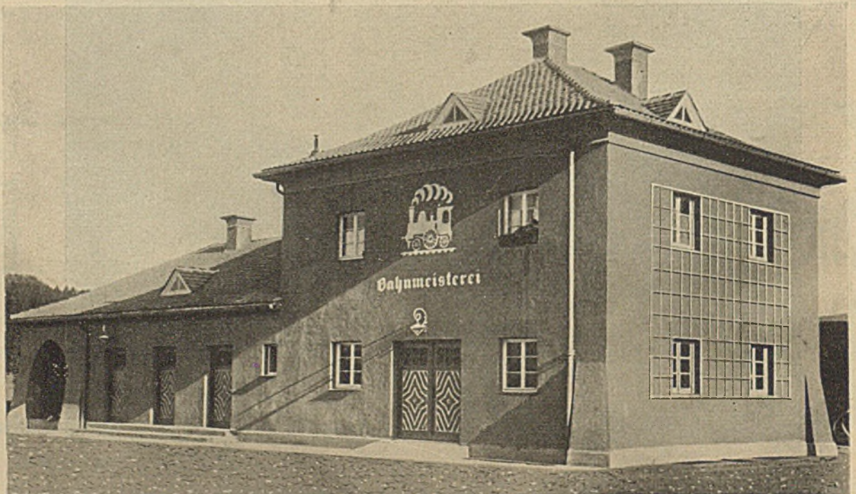
* Bahnmeisterei Bad Tölz
