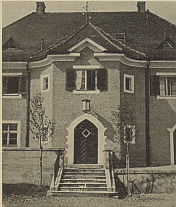
* Betriebsgebäude Penzberg, Teil-Ansicht
