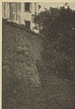
Alte Ringmauer aus Bruchstein in Hohenschäftlarn
