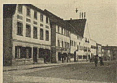
Häuserzeile in Wolfratshausen mit geschlossener Wirkung durch einheitlichen Maßstab. Die verschiedenartigen Dachformen stören nicht
