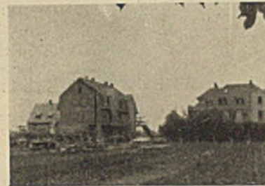
Genossenschaftshäuser mit schlechten Dachformen
