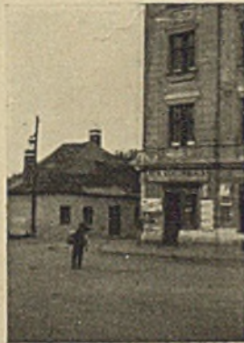
Haus Ortnergasse Nr. 30 in Klosterneuburg, mit häß- licher Mietkaserne davor
