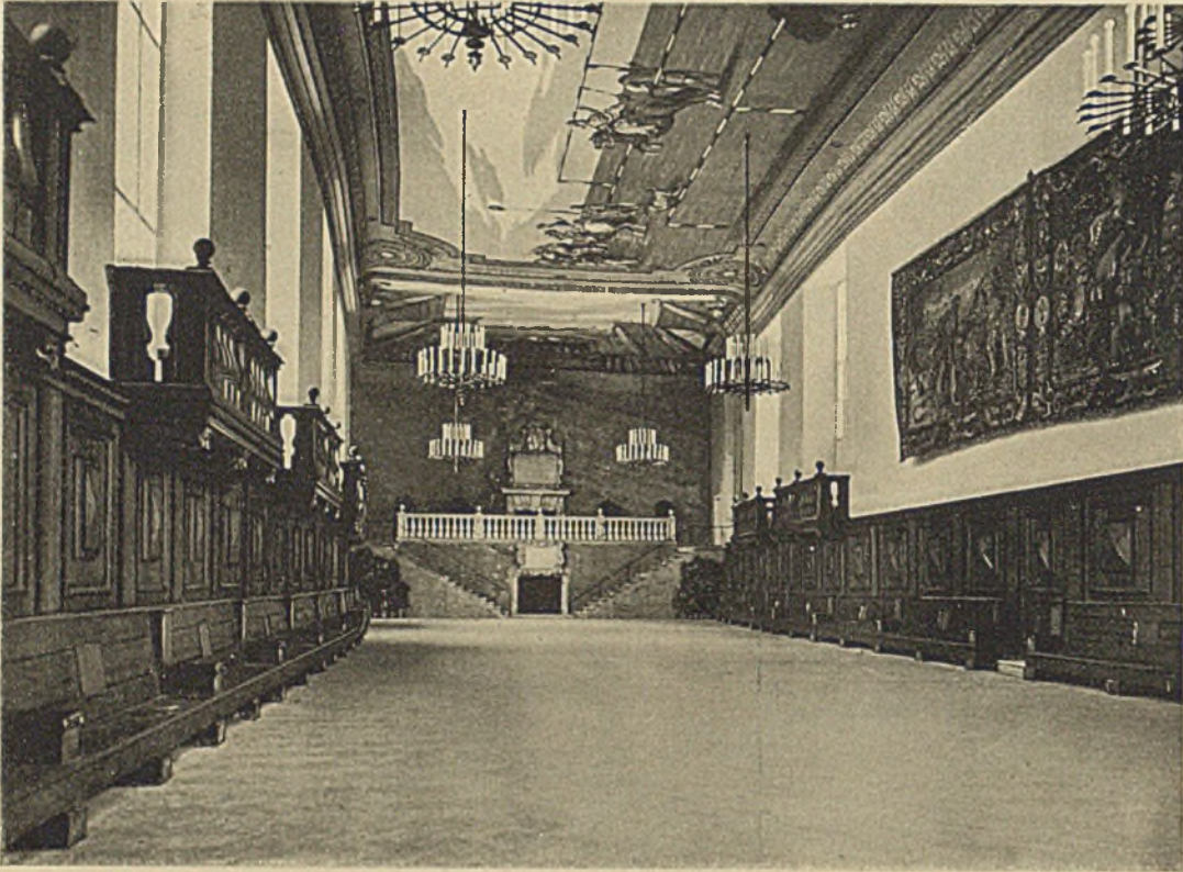
Stadtsaal [umgebau- te ehemalige Winterreitschule]
