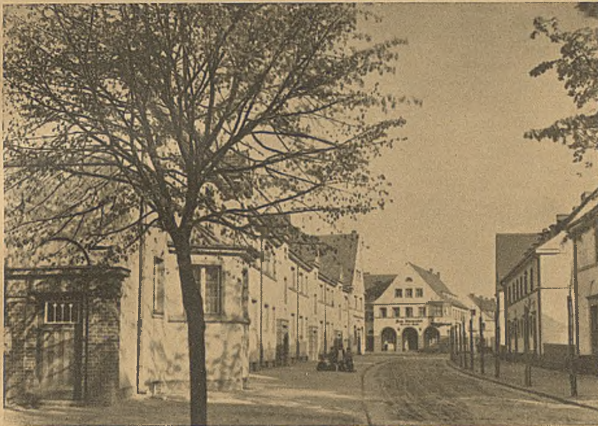
Siedlung am Dammweg Berlin-Neukölln — Strasse 37
