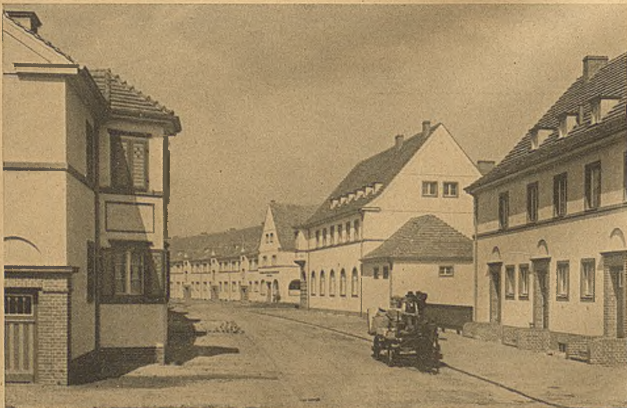
Siedlung am Dammweg Berlin-Neukölln — Strasse 36
