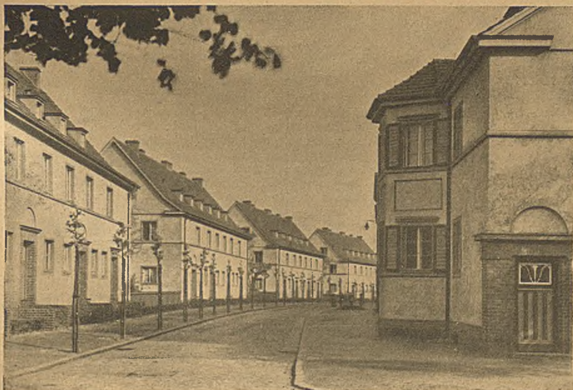
Siedlung am Dammweg Berlin-Neukölln — Strasse 38
