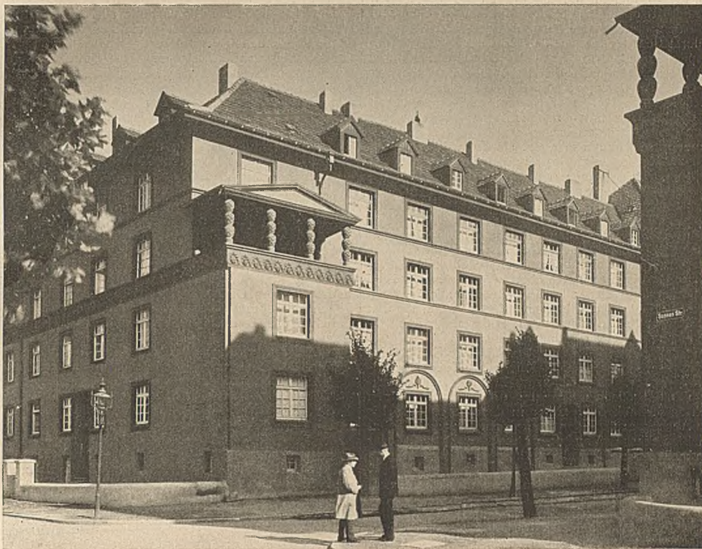
• Viergeschosshäuser der Dortmunder Wohnbaugesellschaft
