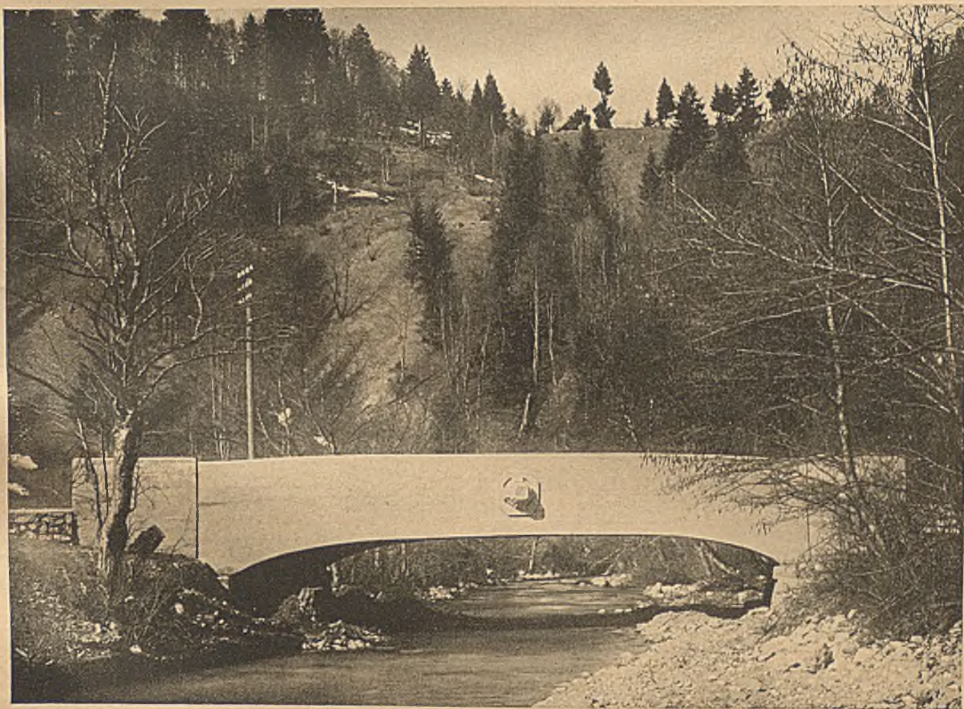
PARNACHBRÜCKE BEI PARTENKIRCHEN Ausgef. für Gemeinde Partenkirchen durch Wayss & Freytag, A.-G.
